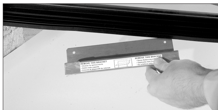
Rys. 2. Usunąć wspornik transportowy szklanych drzwi wahadłowych, jeśli jest w wyposażeniu. Nie wyrzucać go.
