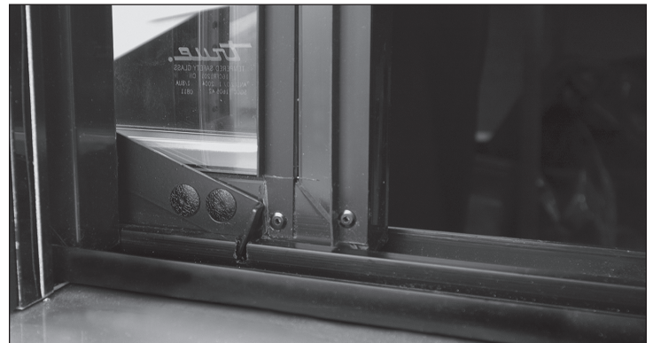
Fig. 1. El cerrojo de la puerta está en posición abierta (enganchado con la hendidura).
