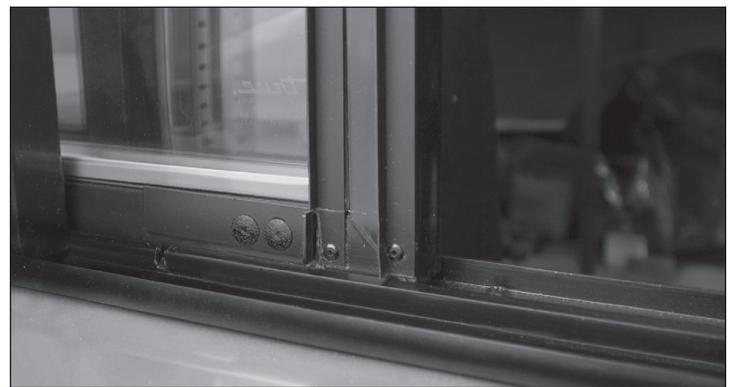
**Fig. 2.** El pestillo de la puerta está en posición cerrada (desenganchado de la muesca).
