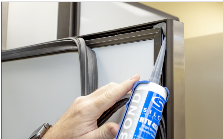
Rys. 3. Nałożyć silikon na każdy róg kanału uszczelki.
