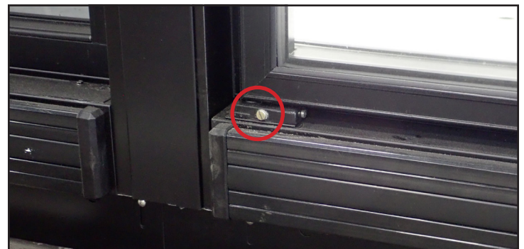
Fig. 4. Emplacement de la vis de réglage de la tension de la porte en bas de la porte.
