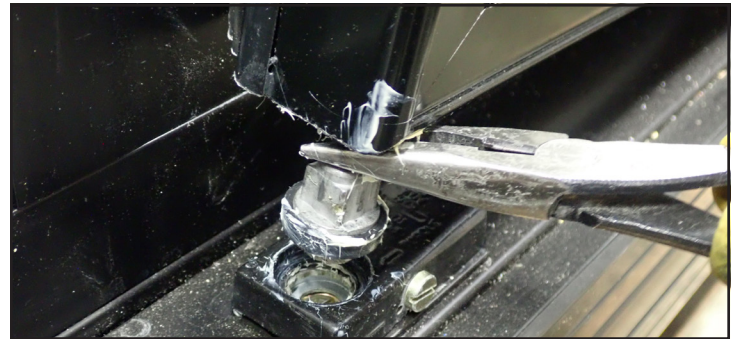
Fig. 7. Un assistant soulevant la tige de torsion du trou du torque master pendant que le technicien soulève la porte.
