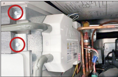
Afb. 3. Zijaanzicht TRUEZONE uv-systeem. Locaties van schroeven voor TRUEZONE-houder.
