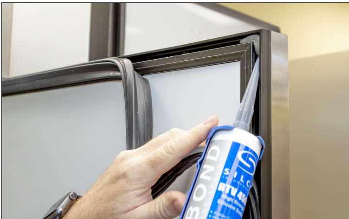
Fig. 3. Appliquez du silicone à chaque coin du canal de joint.
