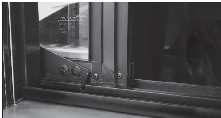
Fig. 1. Le verrou de la porte est en position ouverte (engagé dans l'encoche).
