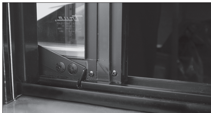
Abb. 1. Feststellriegel geöffnet (in Nocke eingerastet)
