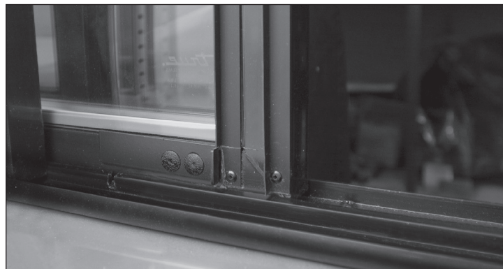
Abb. 2. Feststellriegel geschlossen (nicht in Nocke eingerastet)
