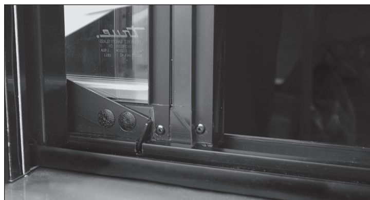
Rys. 1. Zatrask drzwi jest w pozycji otwartej (zatrzaśnięty z wycięciem).
