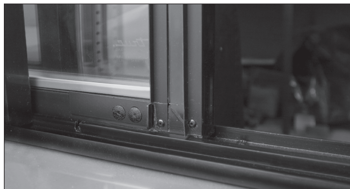
Rys. 2. Zatrask drzwi jest w pozycji zamkniętej (odłączony od wycięcia).
