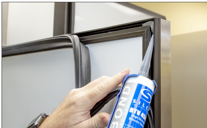
Рис. 3. Нанесите силикон в каждом углу направляющей уплотнителя.
