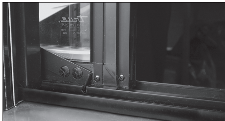
Рис. 1. Дверная задвижка в открытом положении (введена в выемку).
