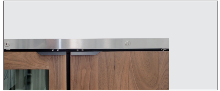
Fig. 11. Tiradores de la puerta instalados.
