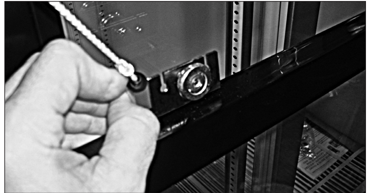
Fig. 6. Deslice la lengüeta negra que sujeta el cable de la puerta hacia la parte trasera.
