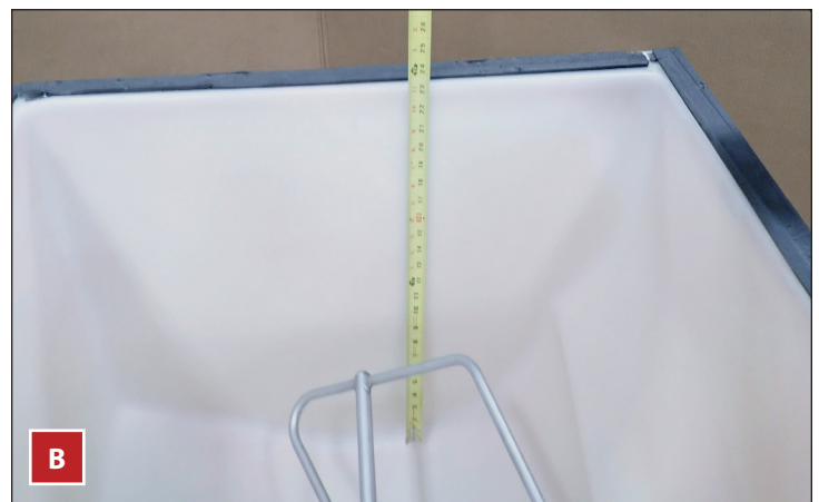
Abb. 2. Messen Sie stets den Behälter (A) oder Spender (B) für den Eisfüllstandsensor, bevor Sie den Eisbereiter montieren.
