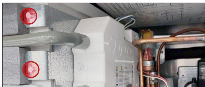
Rys. 3. Widok z boku systemu UV TrueZone. Położenie śrub wspornika TrueZone.
