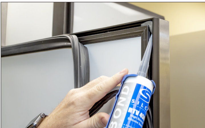
Afb. 3. Breng silicone aan in elke hoek van de pakkinggleuf.
