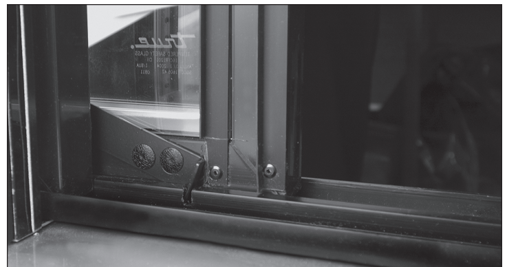
Abb. 1. Feststellriegel geöffnet (in Nocke eingerastet)
