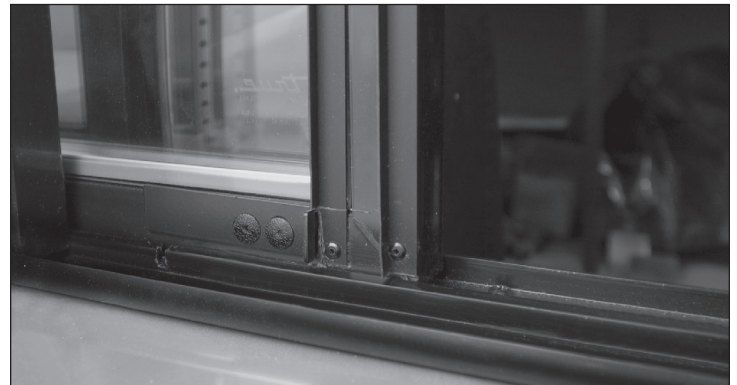
Abb. 2. Feststellriegel geschlossen (nicht in Nocke eingerastet)
