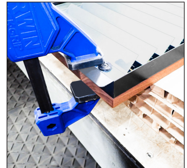
Abb. 2. Verkleidung und Gitter an den Ecken aneinander ausrichten. Die Verkleidung ist etwas größer als das Gitter.
