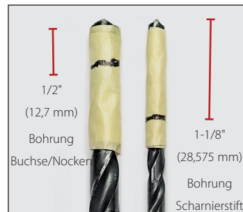
Abb. 8. Die Bohrtiefe an den Bohrern markieren.
