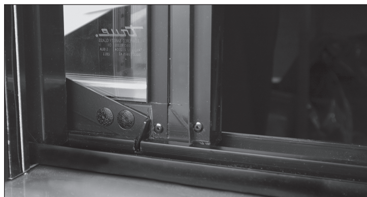
Fig. 1. La serratura dello sportello è in posizione aperta (innestata nell'incavo).
