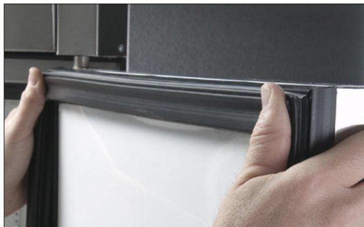
Rys. 4. Często zdarza się, że silikon jest wypychany z toru wokół uszczelki. W ten sposób wiadomo, że użyto wystarczającej ilości silikonu.
