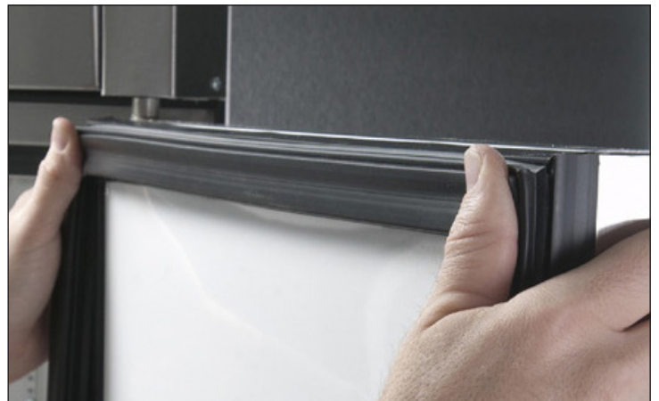
Fig. 4. Es normal ver que la silicona se sale del riel alrededor de la junta. Así se sabe que se ha utilizado suficiente silicona.
