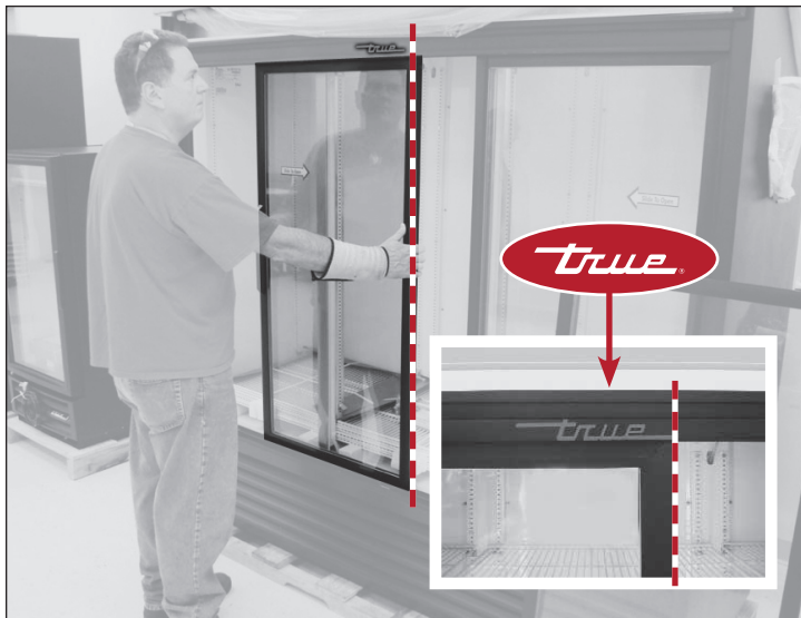
Fig. 6. Alignez le bord droit de la porte gauche sur le bord droit du logo TRUE.
