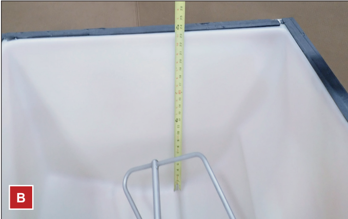
الشكل 2. قم دائمًا بقياس الصندوق (A) أو الموزع (B) الخاص بمستشعر مستوى الثلج قبل تركيب آلة الثلج
