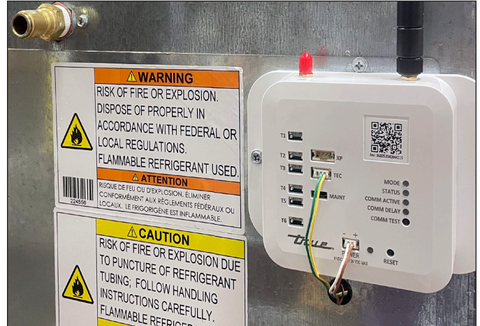
الشكل 2. مجموعة أسلاك متصلة بجهاز الوصل. توصيل الأخضر/ الأصفر بـ TEC؛ والبني/ الأبيض بمصدر الطاقة.
