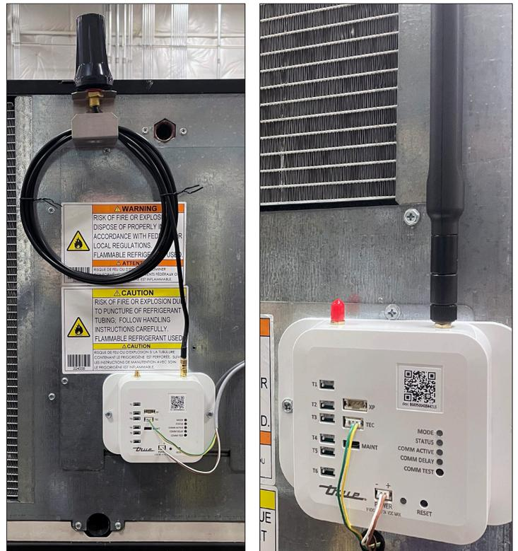
Figure 3. Antenne installée sur le modem. Votre antenne peut être différente.
