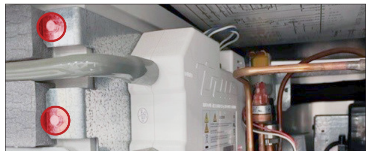
Rys. 3. Widok z boku systemu UV TrueZone. Położenie śrub wspornika TrueZone.
