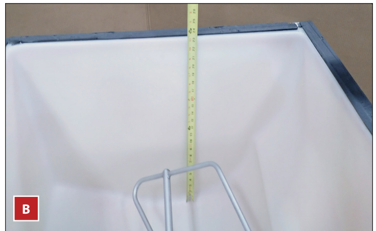
Fig. 2. Mida siempre el depósito (A) o el dispensador (B) para el sensor de nivel de hielo antes de montar la máquina de hielo.
