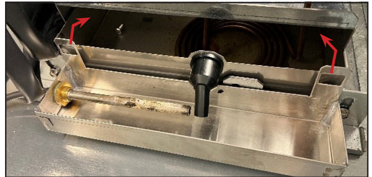
Fig. 3. Doble las lengüetas de la BDC para engancharla a la bandeja de drenaje de condensado.
