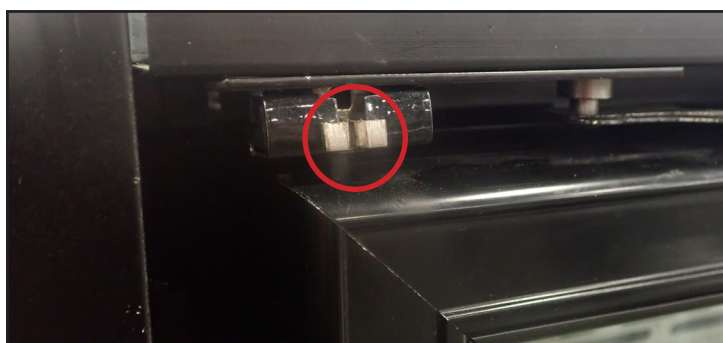
Fig. 6. Clip de maintien de la charnière installé dans la charnière supérieure. Comprimez le clip avec une pince et tirez.
