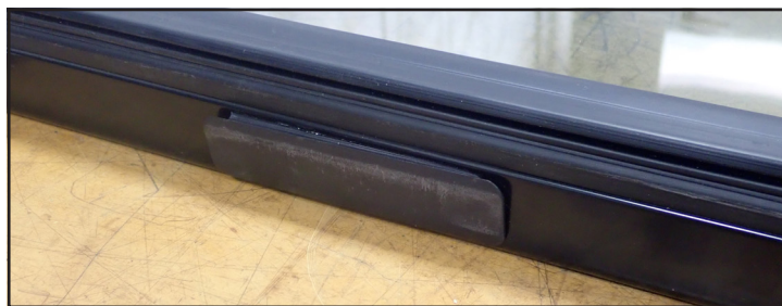
Fig. 17. Cache-câbles situé sur le côté charnières de la porte au centre.
