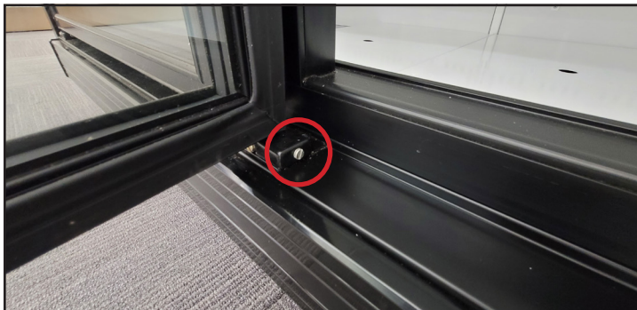
Fig. 3. Emplacement de la vis de réglage de l'alignement de la porte en bas de la porte.
