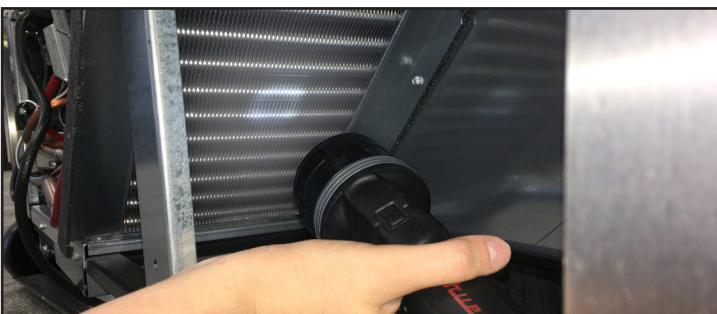
Fig. 4. Compruebe que se hayan eliminado todas las obstrucciones.
