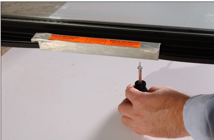
Fig. 2. No retire los soportes de transporte hasta que la unidad esté en su ubicación final.
