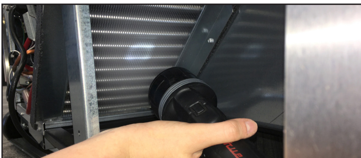
Fig. 4. Verificare che tutti i blocchi siano stati rimossi.
