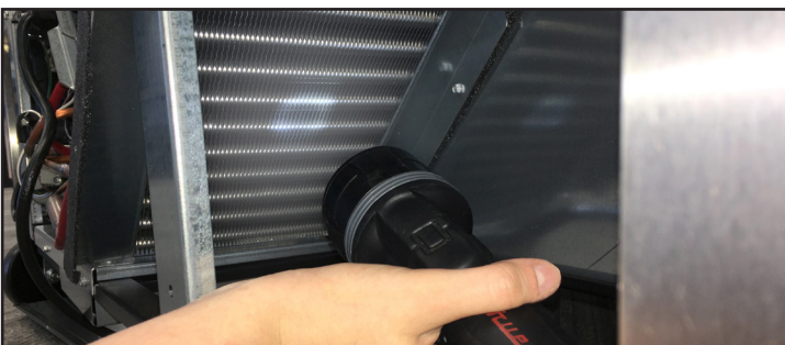
Afb. 4. Controleer of alle verstoppingen verwijderd zijn.
