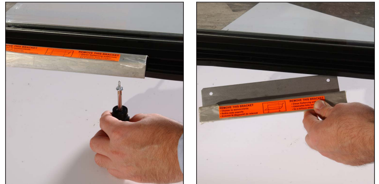
Abb. 2. Transportbügel der Glasschwingtür entfernen. Nicht wegwerfen
