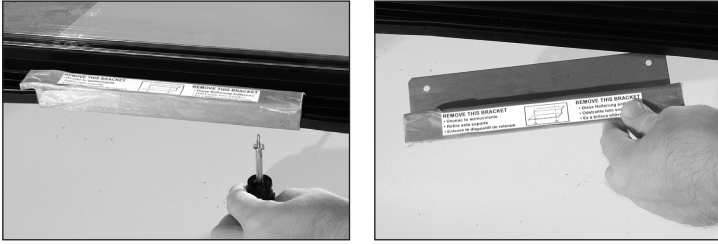
الشكل 2. انزع حامل نقل الباب الزجاجي المتأرجح، إذا كان ذلك مرفقًا. ولا تتخلص منه.
