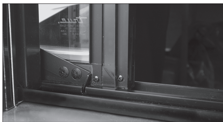
Figure 1. Le verrou de porte est en position ouverte (engagé sur l'encoche).
