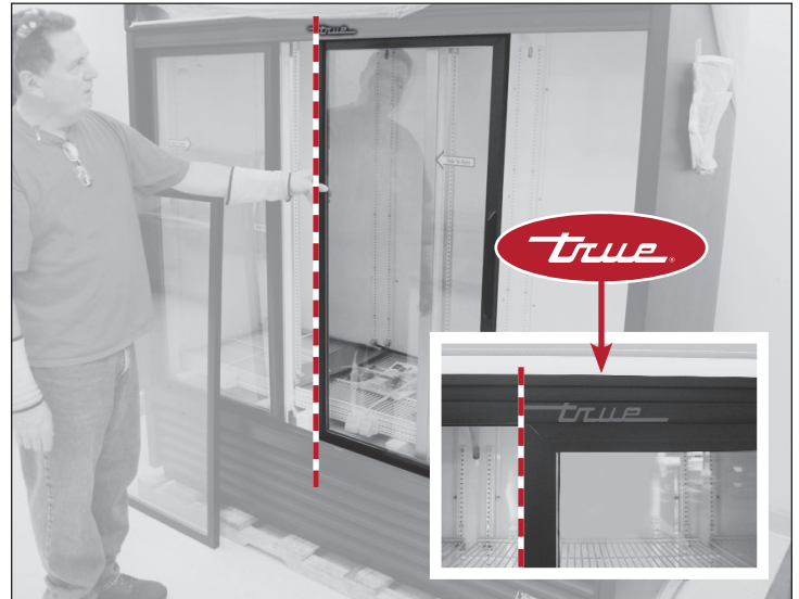
Figure 5. Alignez le bord gauche de la porte droite sur le bord gauche du logo TRUE.
