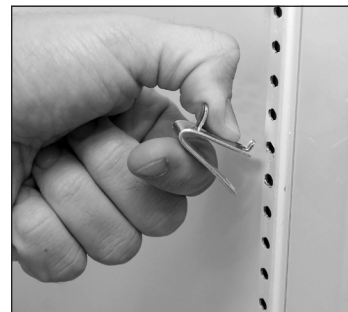
Abb. 1. Anbringen der oberen Lasche des Bodenträgers.
