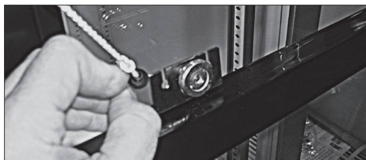
Rys. 8. Wysłanie z tyłu wspornika rolki czarny, plastikowy występ przytrzymujący linkę drzwiową
