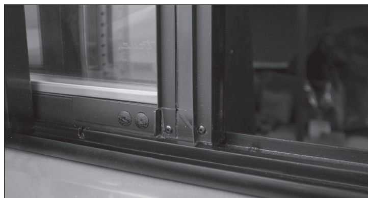
Рис. 2. Защелка дверцы в закрытом положении (не зафиксирована)
