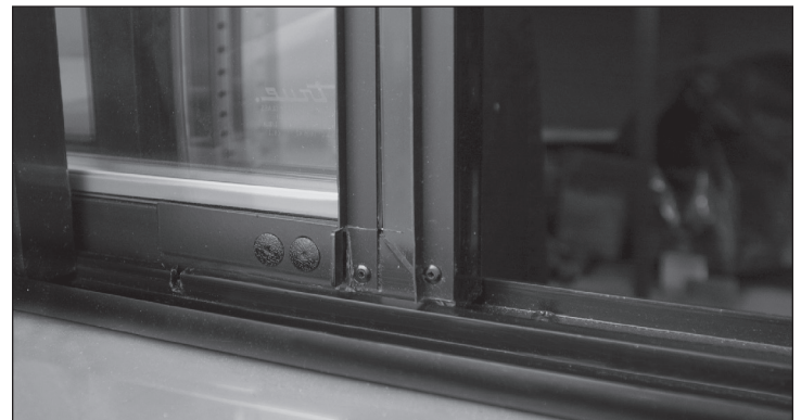
Fig. 2. El cerrojo de la puerta está en posición cerrada (desenganchado de la hendidura).
