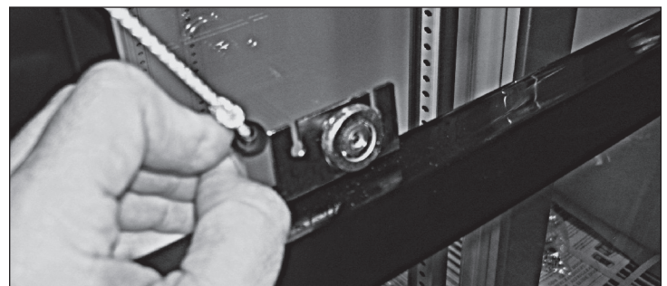
Fig. 8. Deslice la lengüeta negra sosteniendo el cable de la puerta fuera de la parte trasera del soporte del rodillo.
